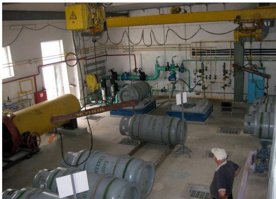
2 – сурет - Хлор қоймасы бар хлоратор
