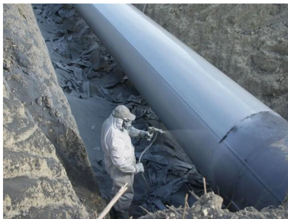
Рисунок 4. Нанесение полимерного покрытия
